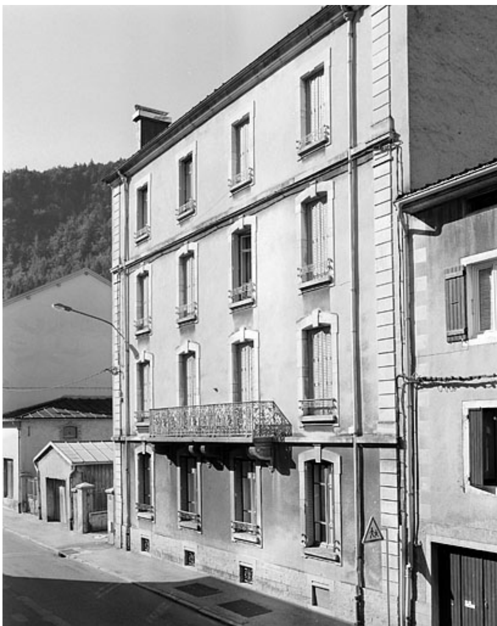
Vue d'ensemble depuis le nord-est : élévation antérieure.
