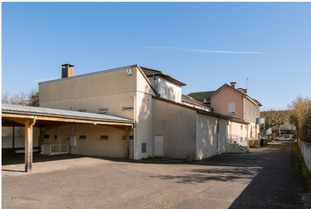
Vue d'ensemble, depuis les garages au sud-ouest.
