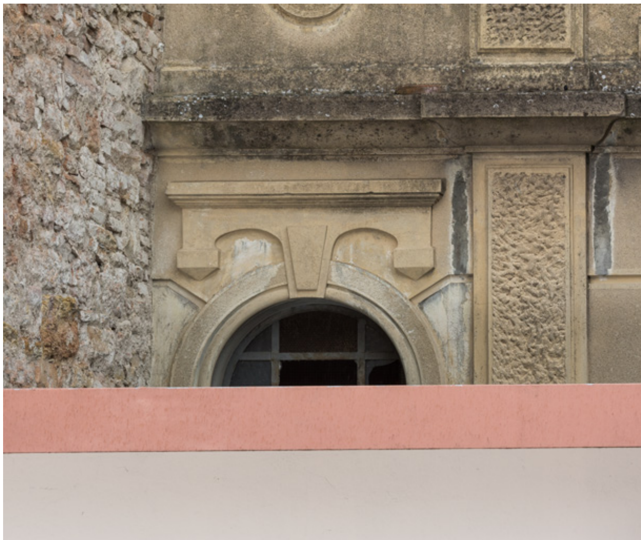
Façade antérieure : décor surmontant une fenêtre.
