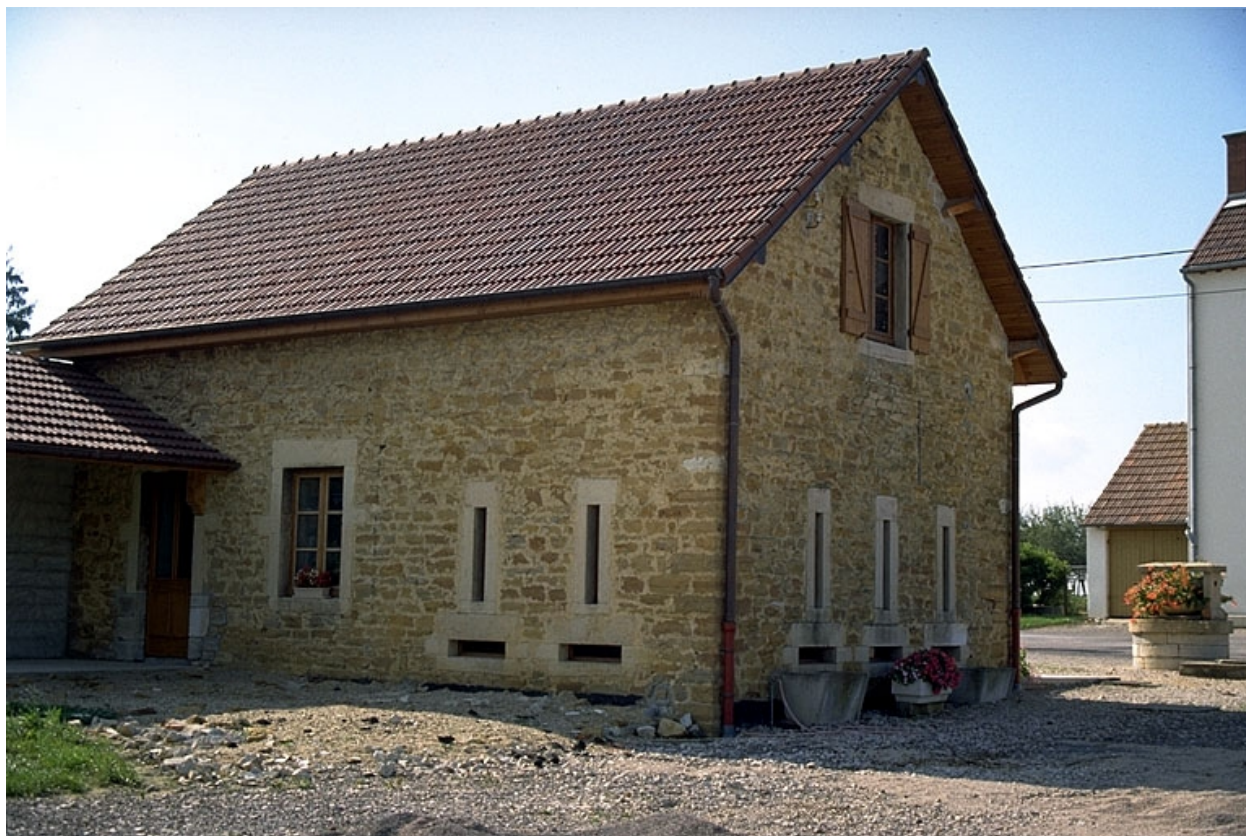
Façades postérieure et latérale gauche.
