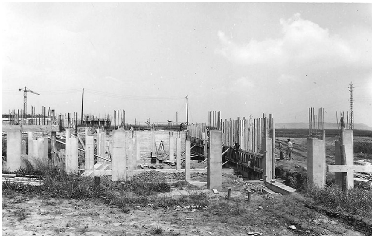
Vue du chantier de construction.
