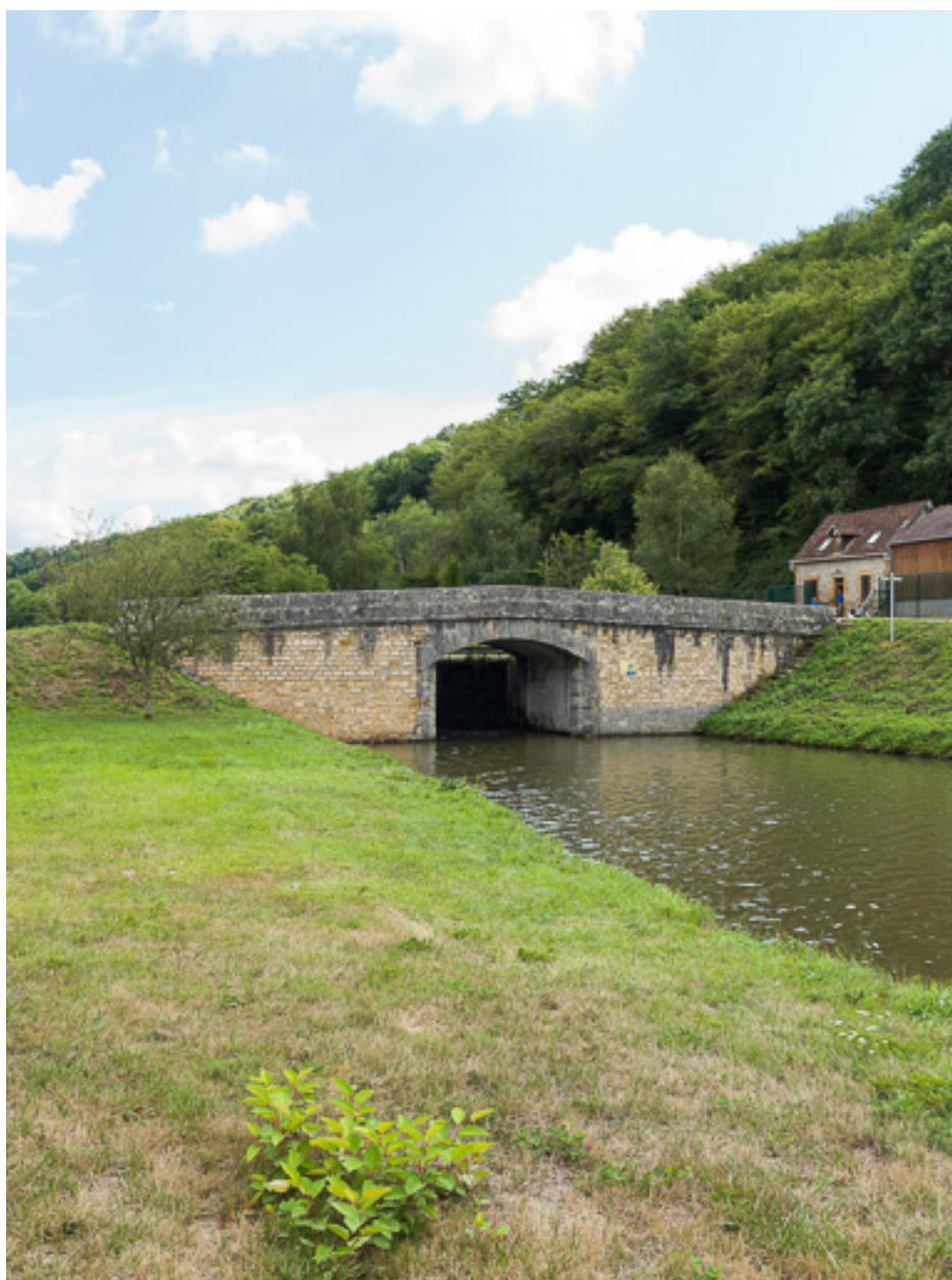
Vue d'ensemble du pont.
