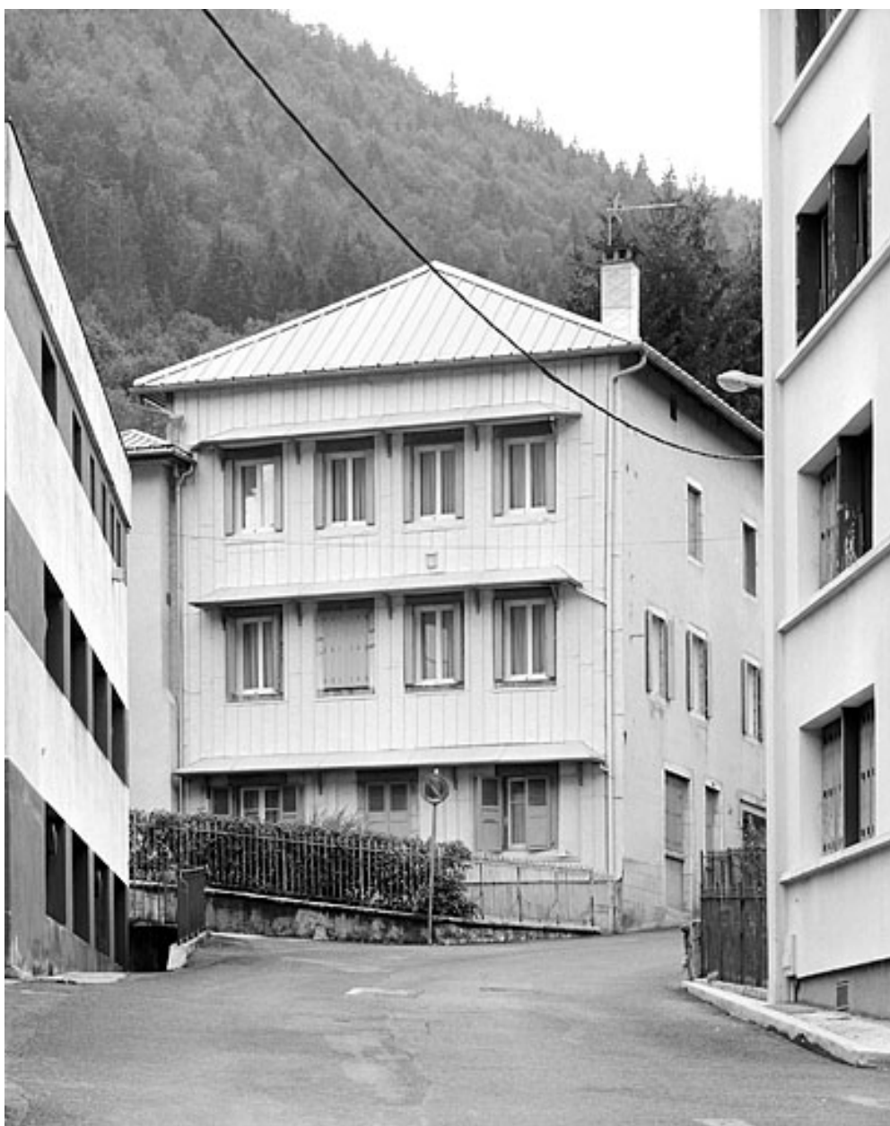
Immeuble : élévation orientale.
