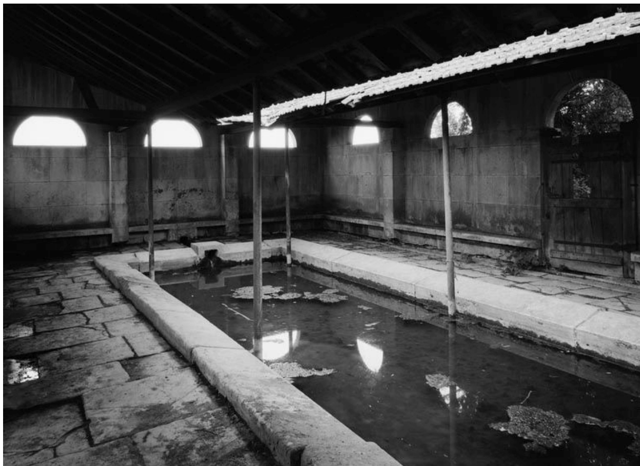
Vue intérieure du lavoir.
