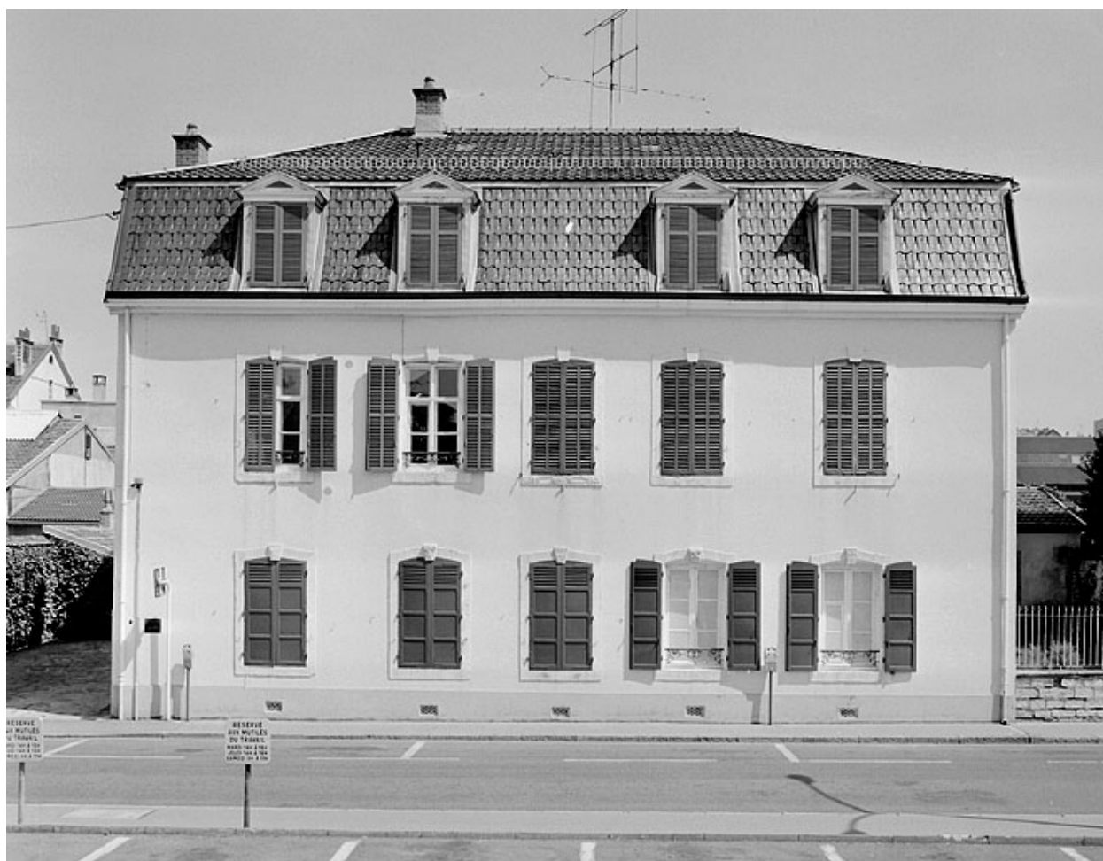
Façade sur rue du corps d'habitation.
