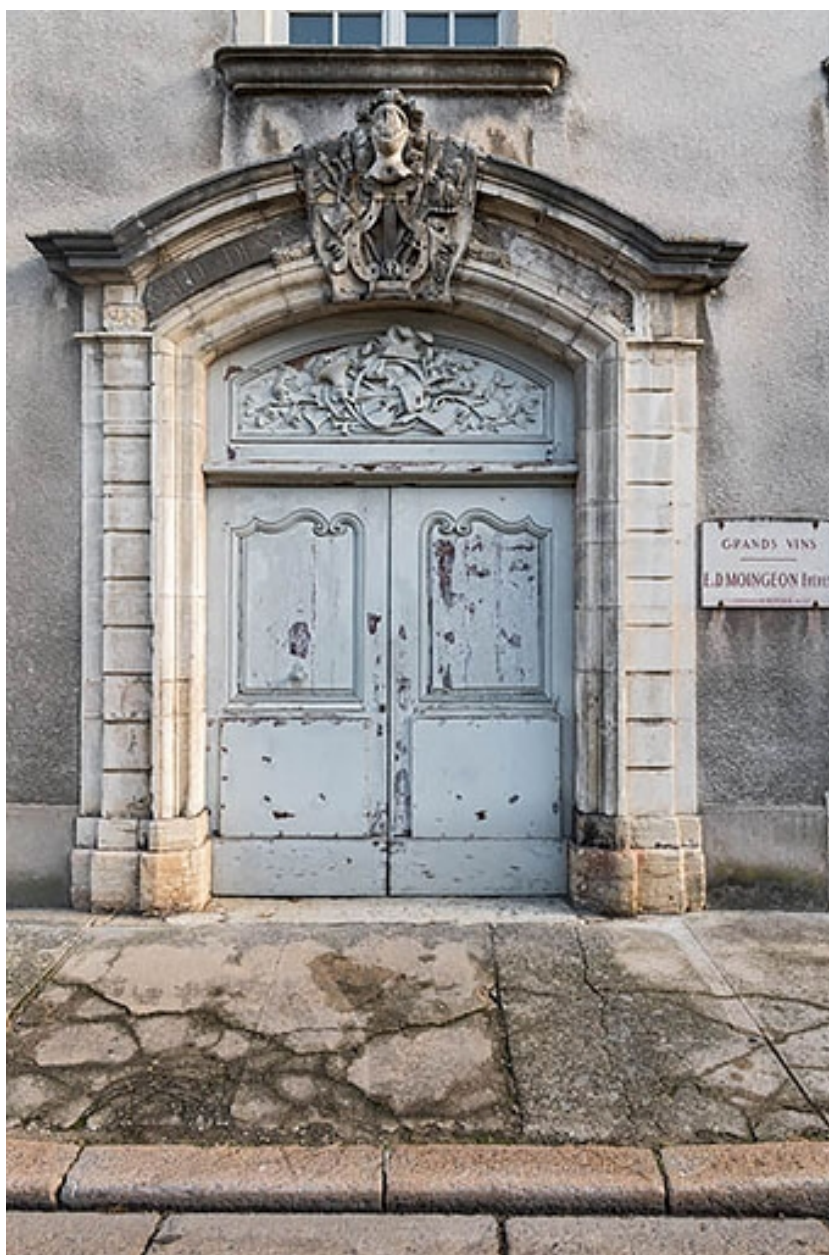
Façade antérieure : portail.
