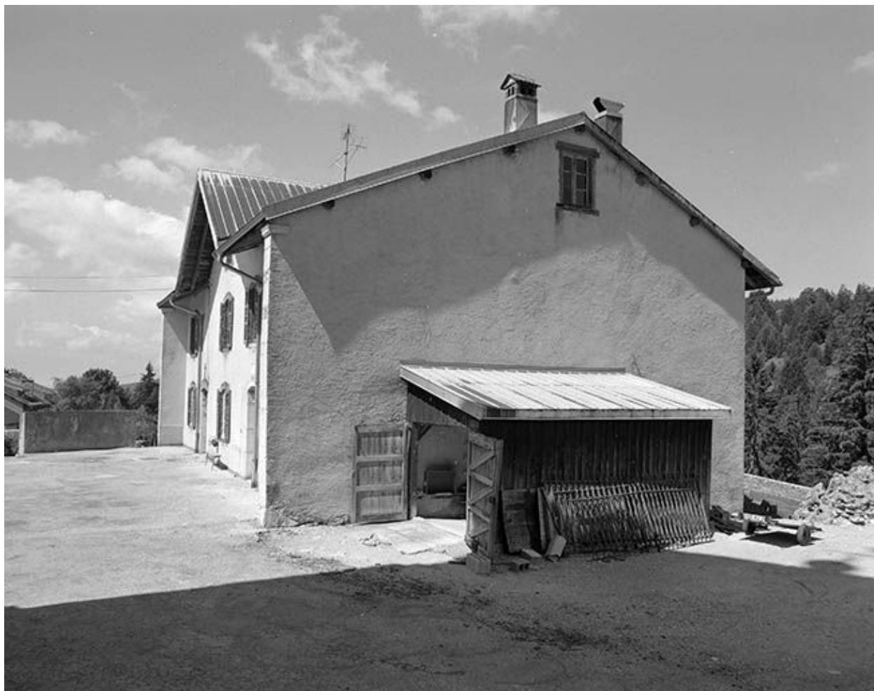
Façade antérieure et face droite.
