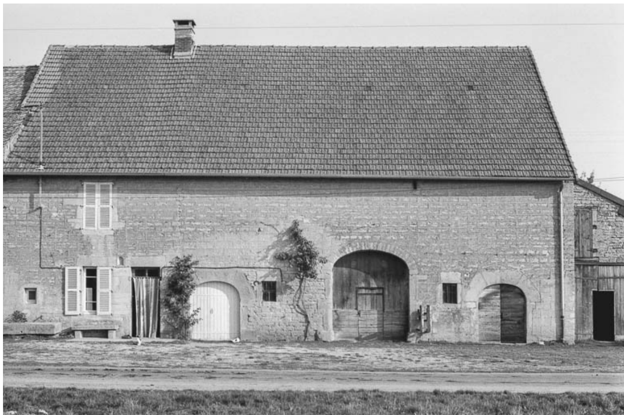
Ferme cadastrée A3 564 : façade antérieure.
