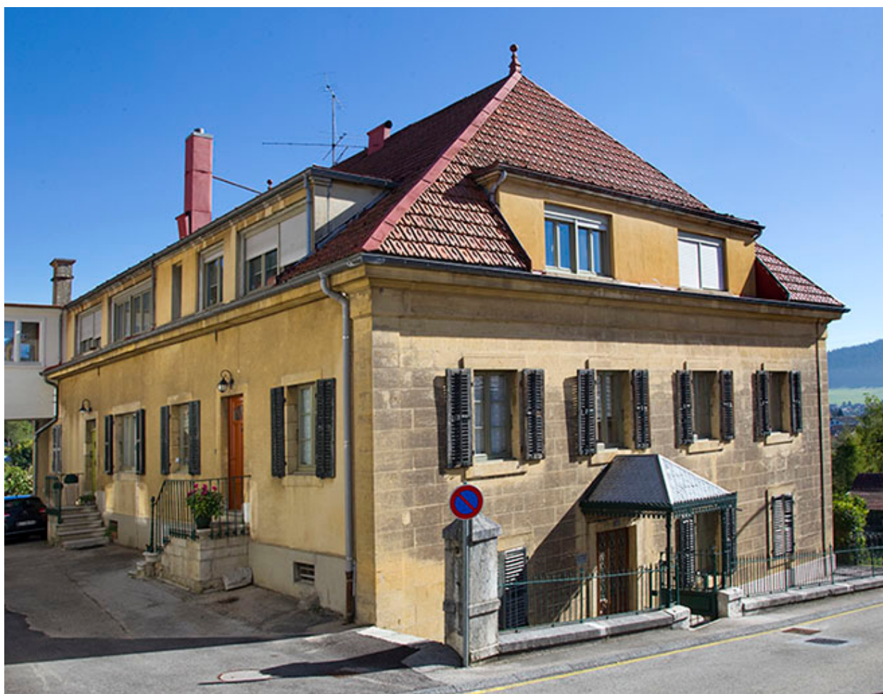
Maison : façades antérieure et latérale gauche.
