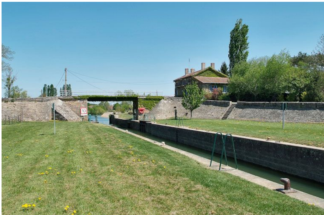
Le sas d'écluse de La Truchère.
