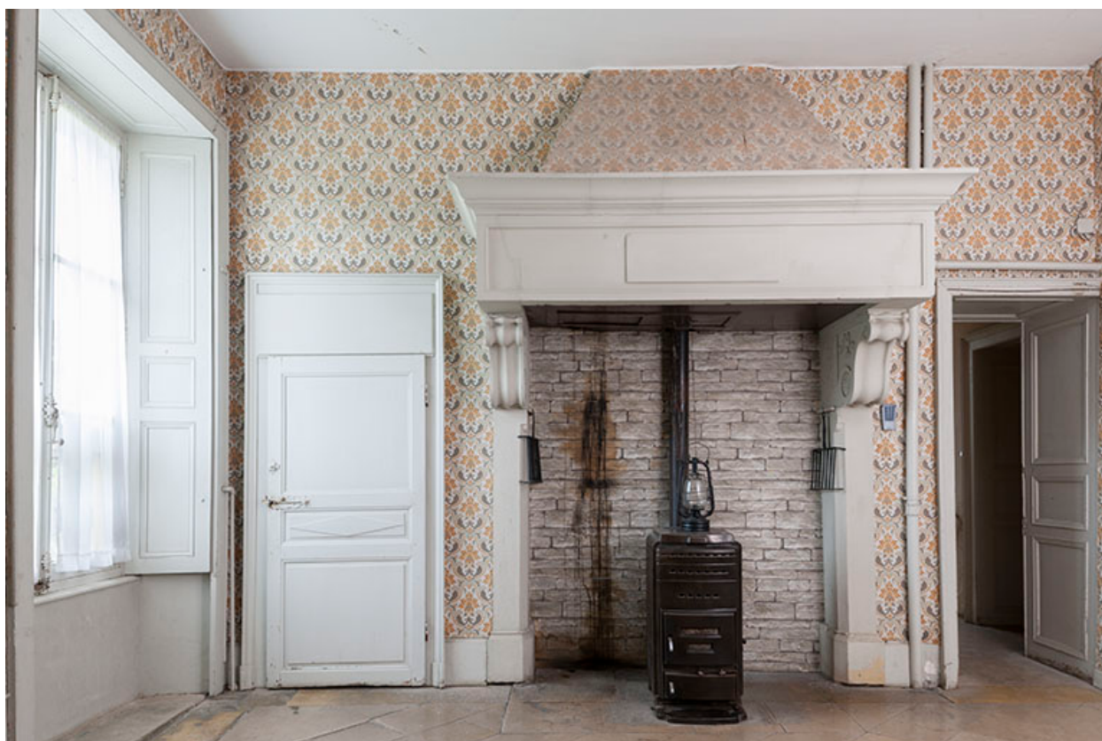
Cheminée de l'ancienne cuisine du rez-de-chaussée.
