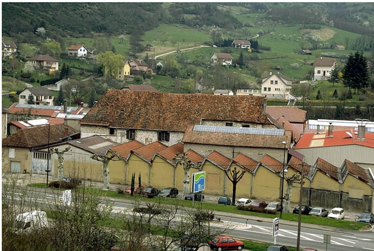
Faïencerie des Capucins, Salins-les-Bains.
