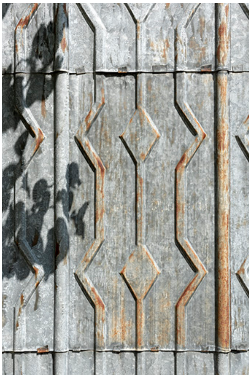
Façade latérale gauche : détail de l'essentage métallique.
