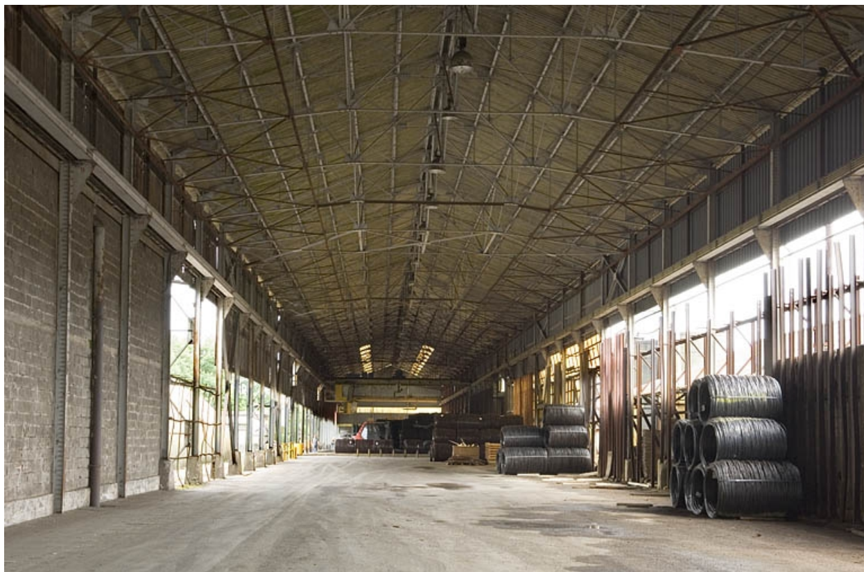
Vue intérieure d'un entrepôt industriel.
