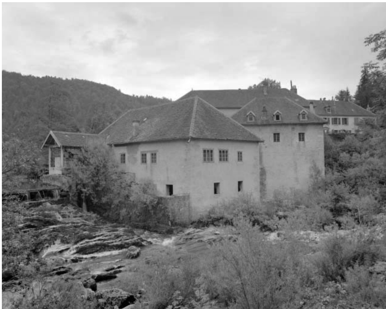
Scierie, vue depuis l'ouest.
