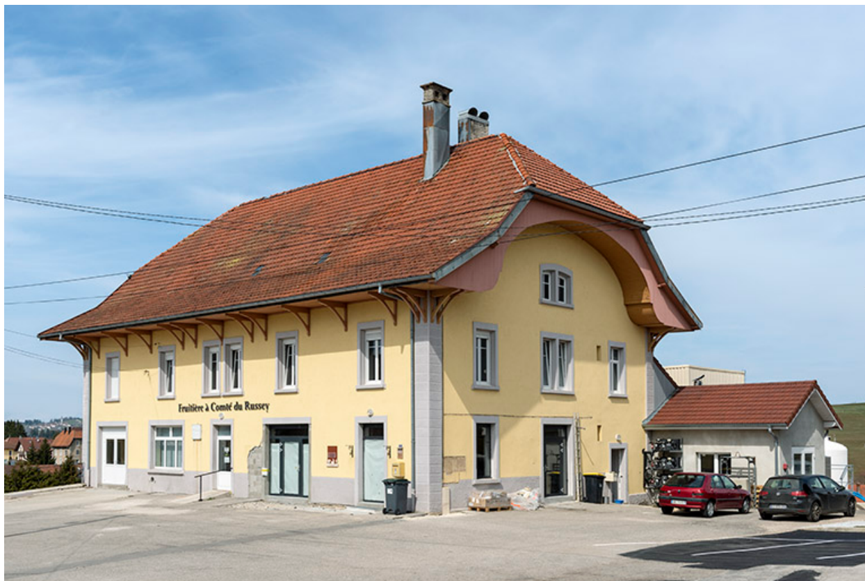
Façades antérieure et latérale droite.
