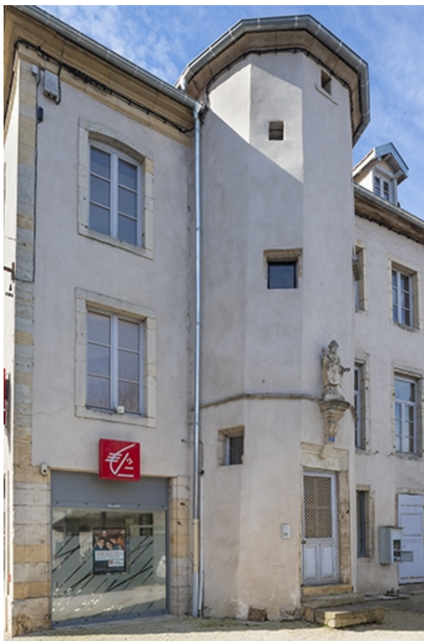
Trois quarts gauche de la tour d'escalier.
