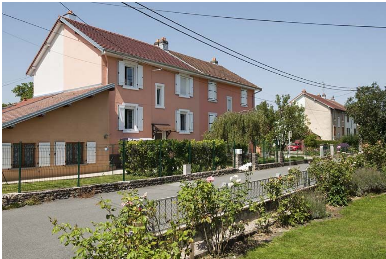
Façade antérieure des habitations.
