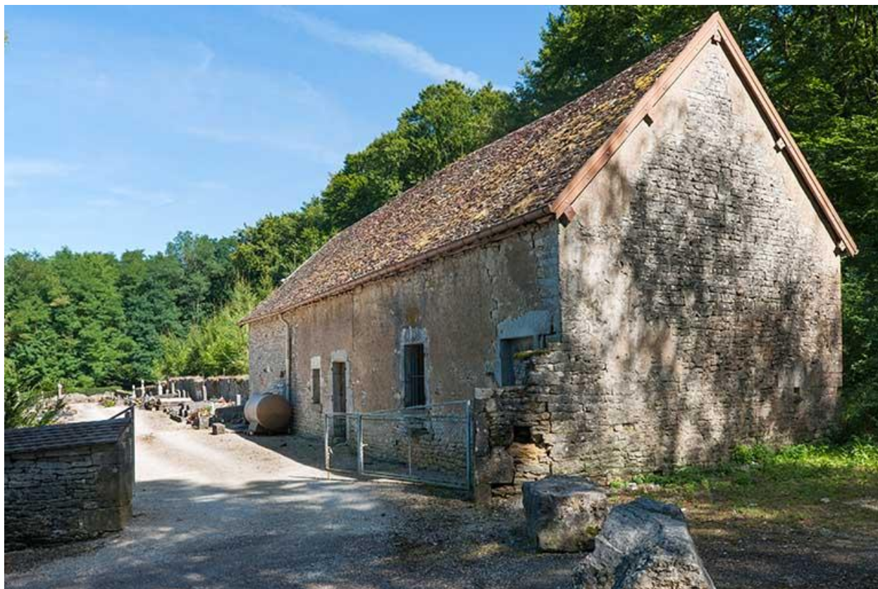
Ancienne ferme située au sud-ouest du cimetière
