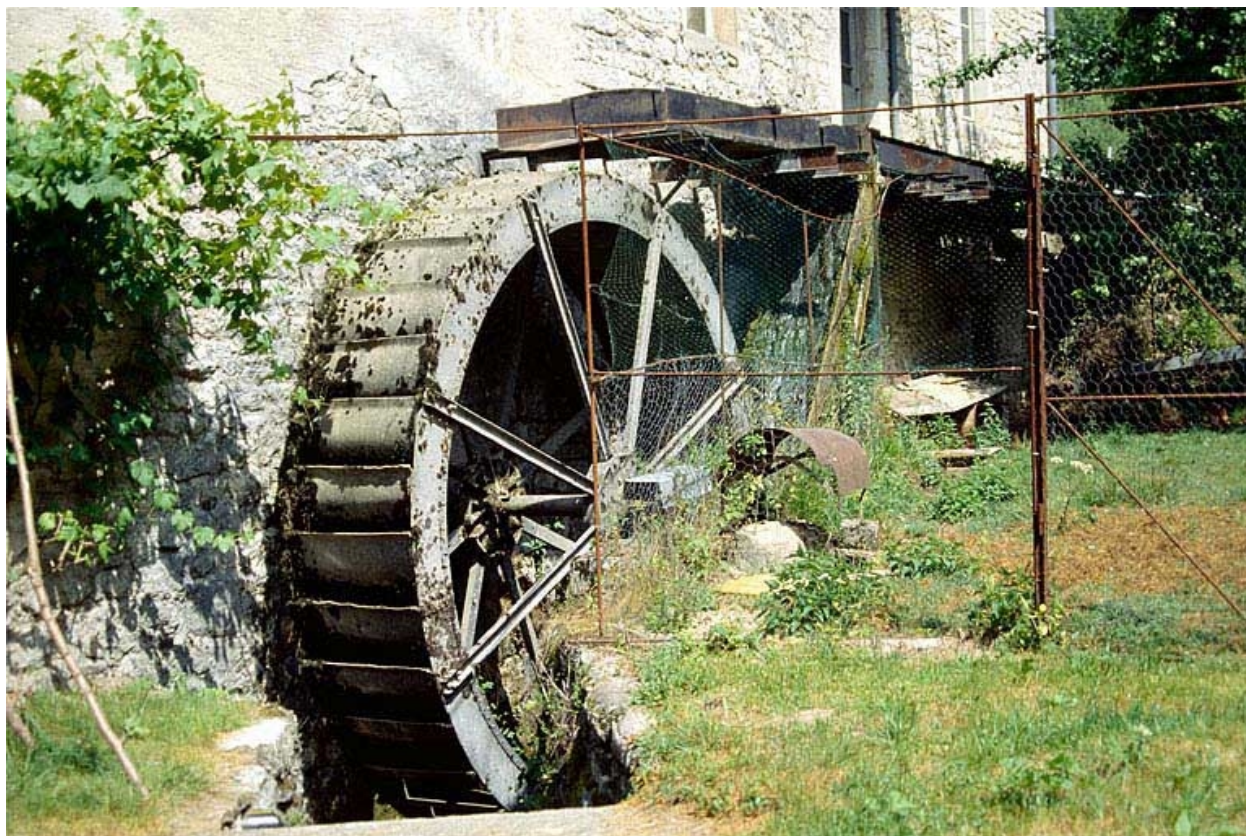
Roue en dessus et conduite d'amenée.
