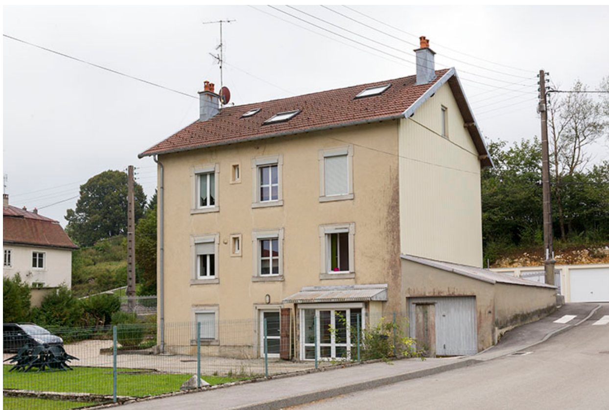
Façades postérieure et latérale gauche.
