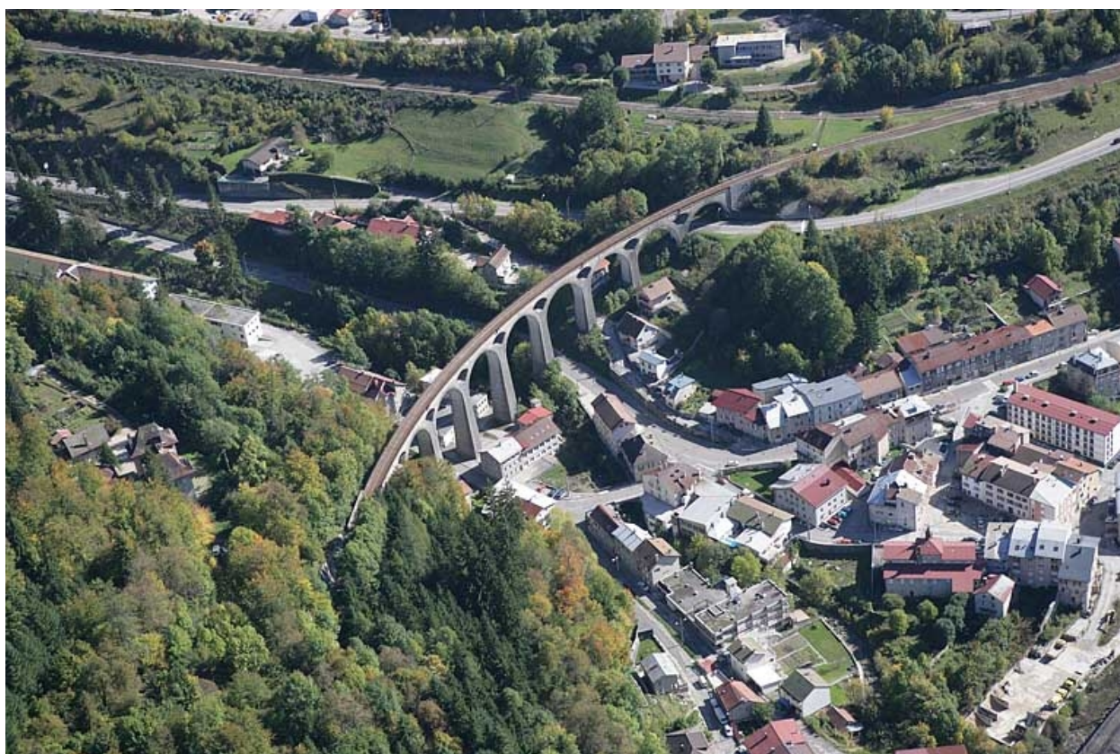
Vue aérienne rapprochée, depuis l'ouest.
