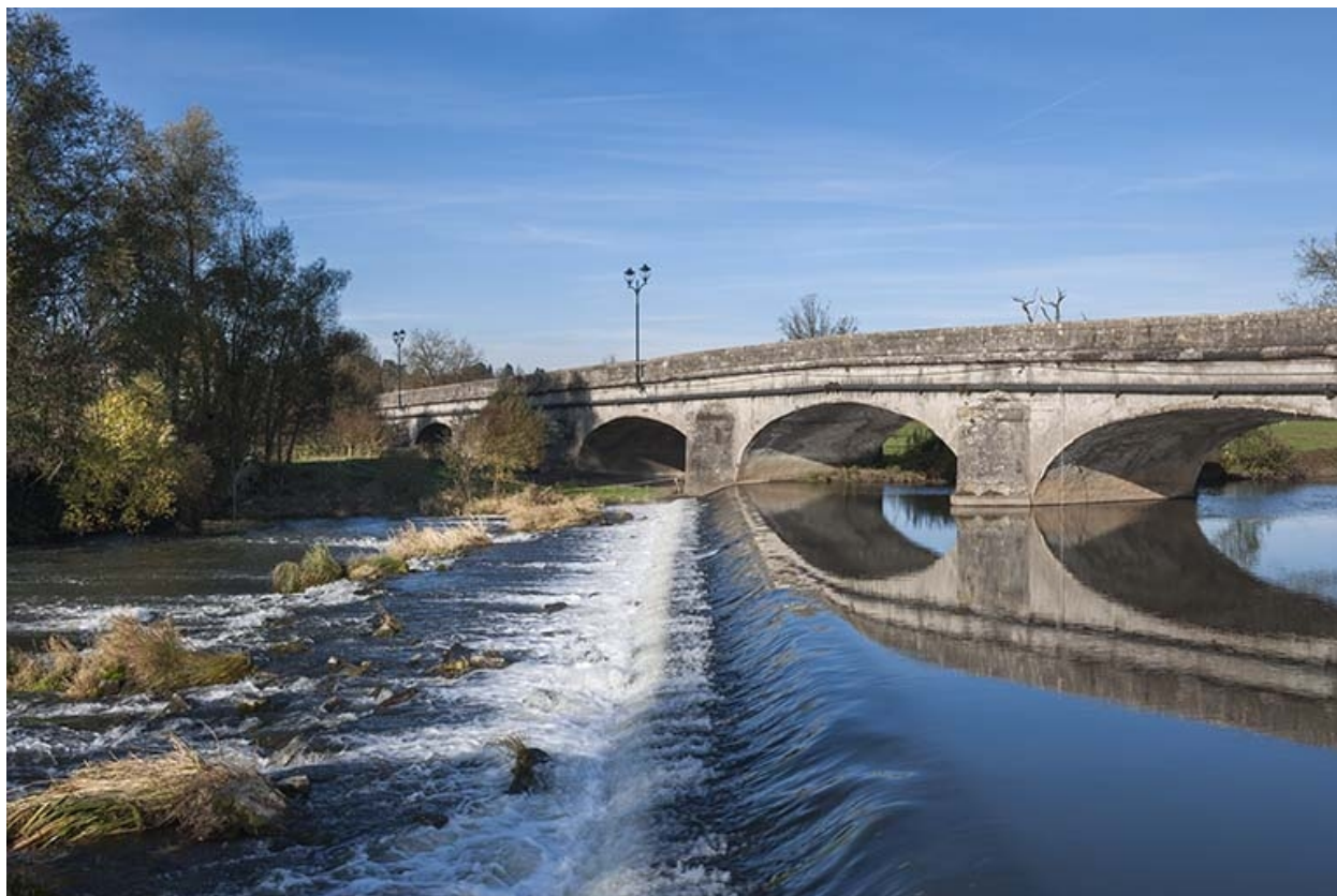
Vue générale depuis l'aval avec le barrage.
