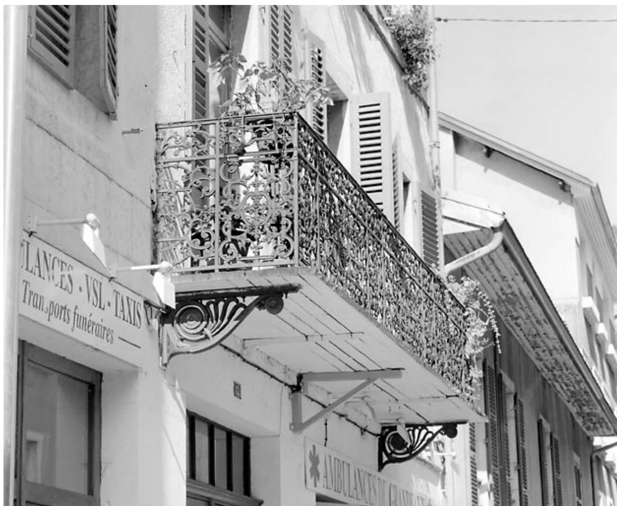
Elévation antérieure : balcon.
