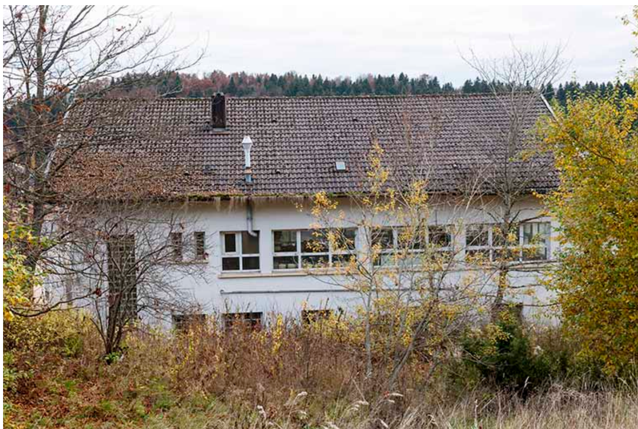
Usine : façade postérieure.
