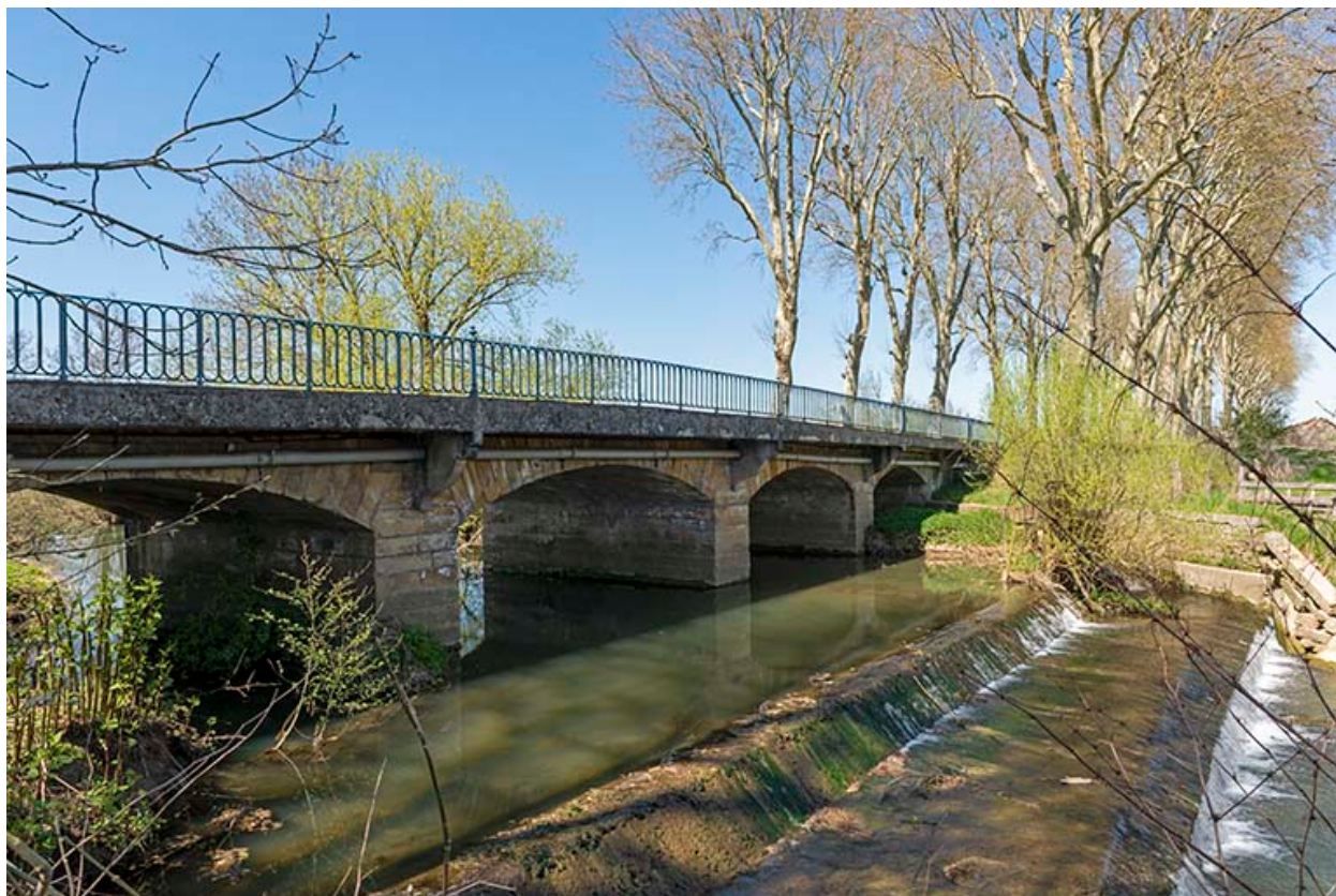
L'ensemble du pont, vu de l'est.
