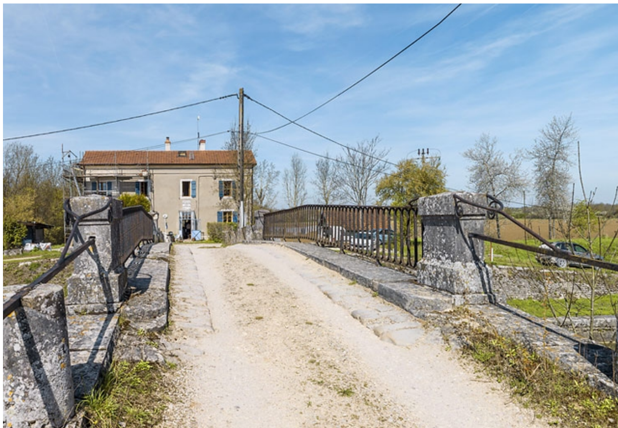
Vue du dessus. Détail des garde-corps.
