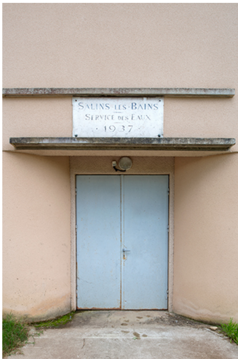
Station de stérilisation (1937). Détail de la porte.
