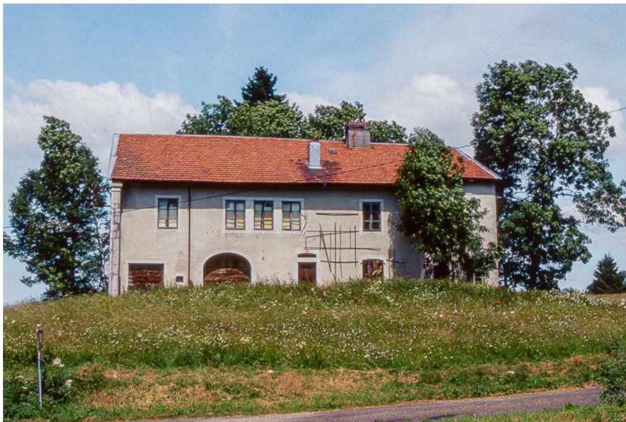
Ferme située au lieudit La Tronche.
