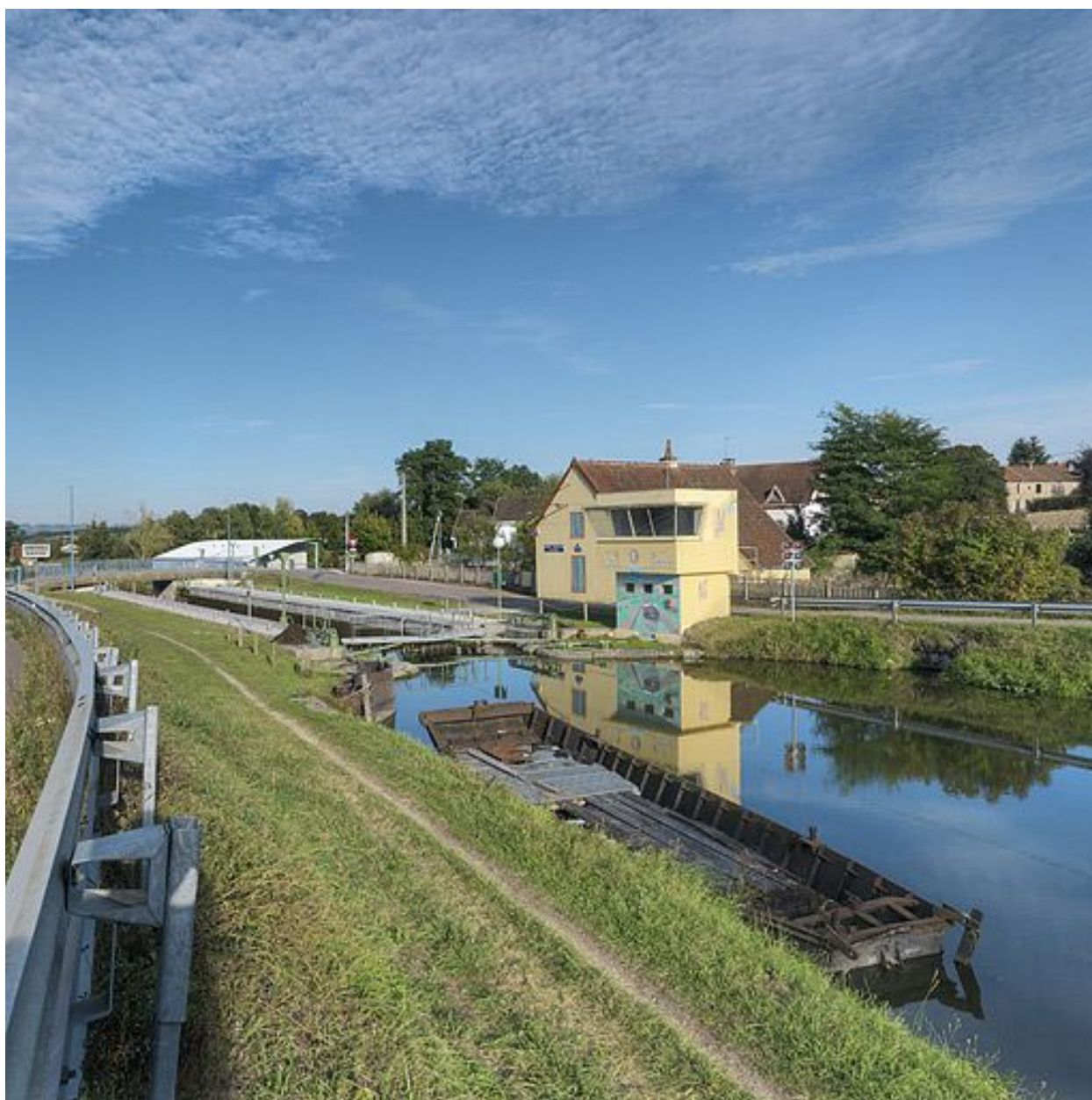
Site d'écluse pris d'amont.
