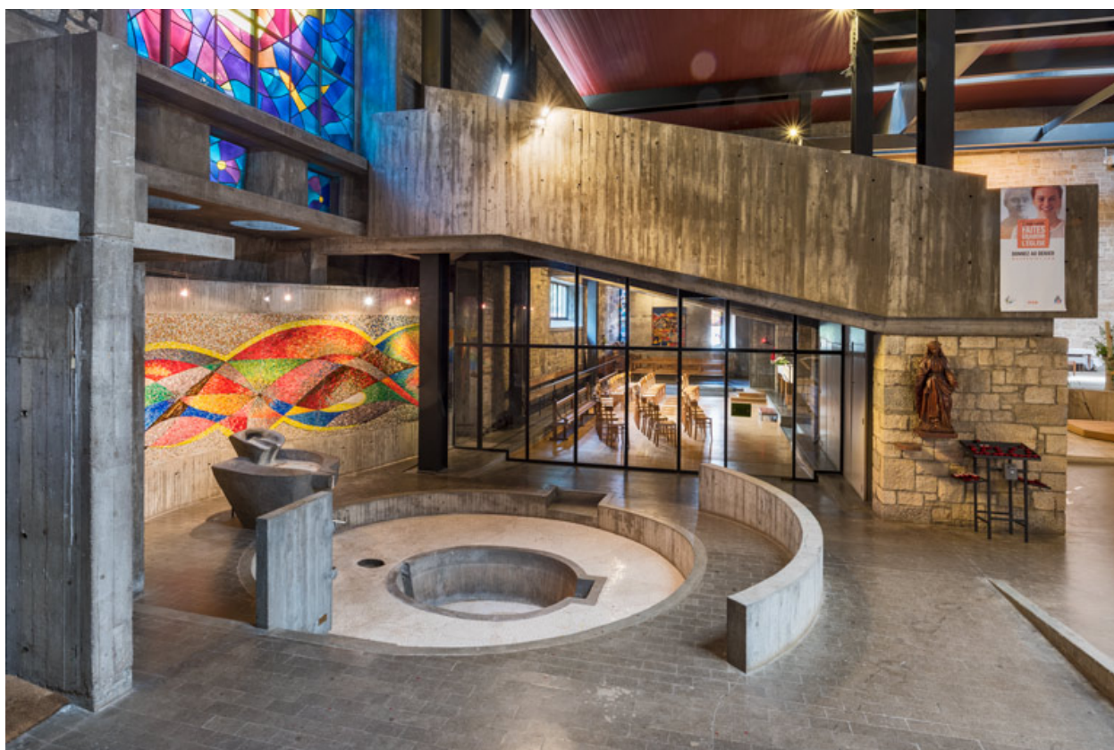
Chapelle des fonts. Vue de côté. Au second plan, la chapelle de semaine sous la tribune ouest.
