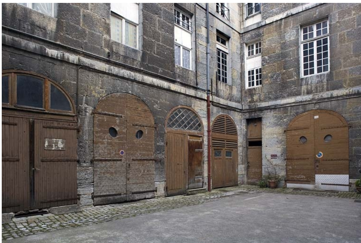
Vue des remises en rez-de-chaussée sur cour.
