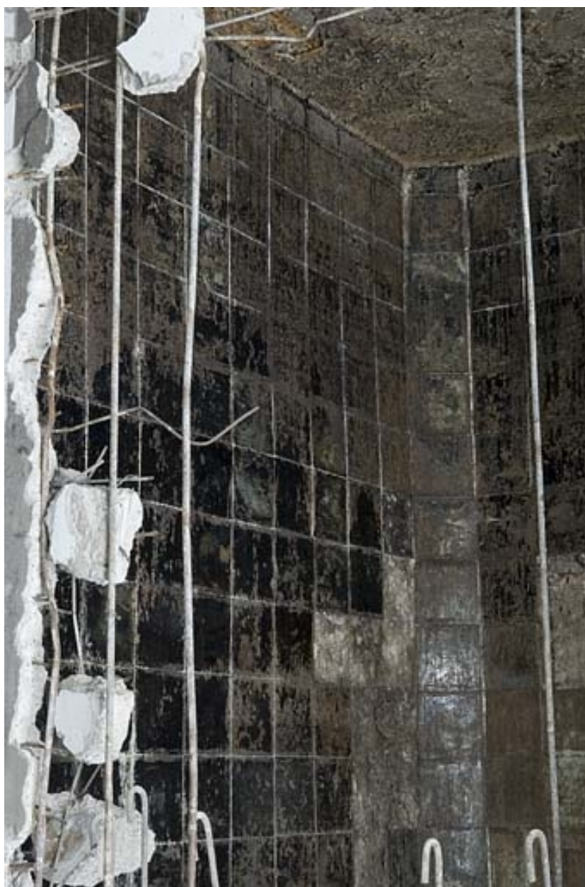
Détail d'une cuve en cours de démolition.
