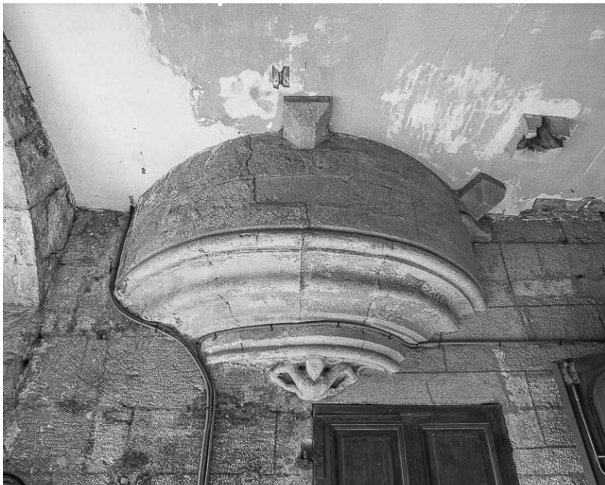
Base de l'escalier de la tour-clocher.
