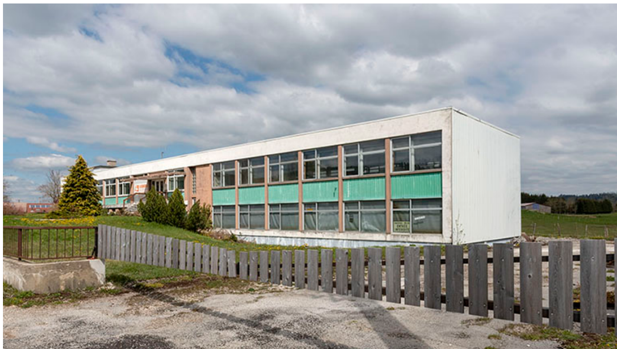
Façades antérieure et latérale droite.
