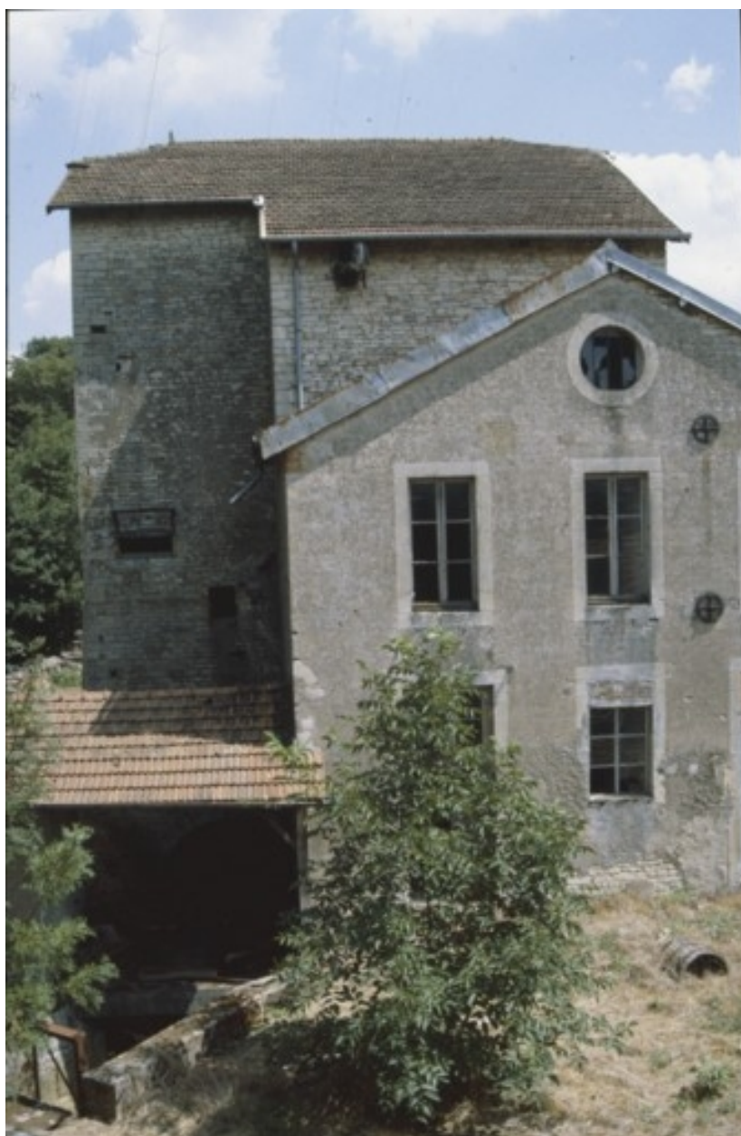
Façade postérieure du haut fourneau en 1989.
