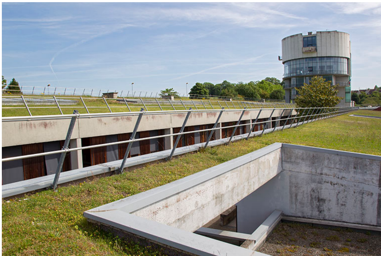
Terrasses et tour vue du sud-ouest.
