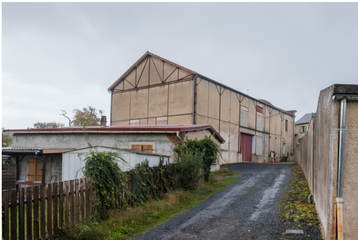
Façades postérieure et latérale gauche.
