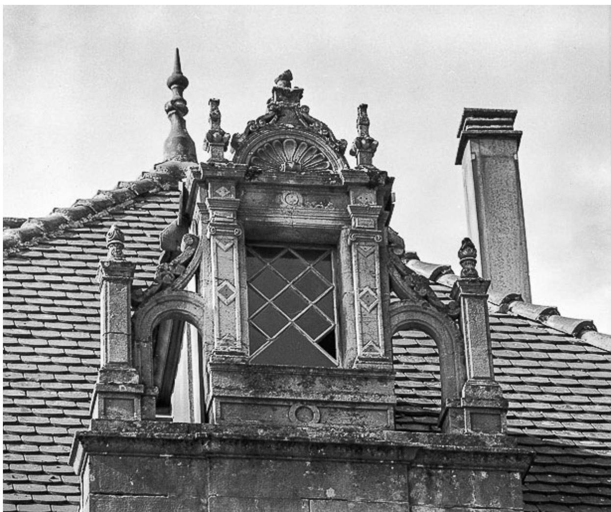
Façade latérale : lucarne.
