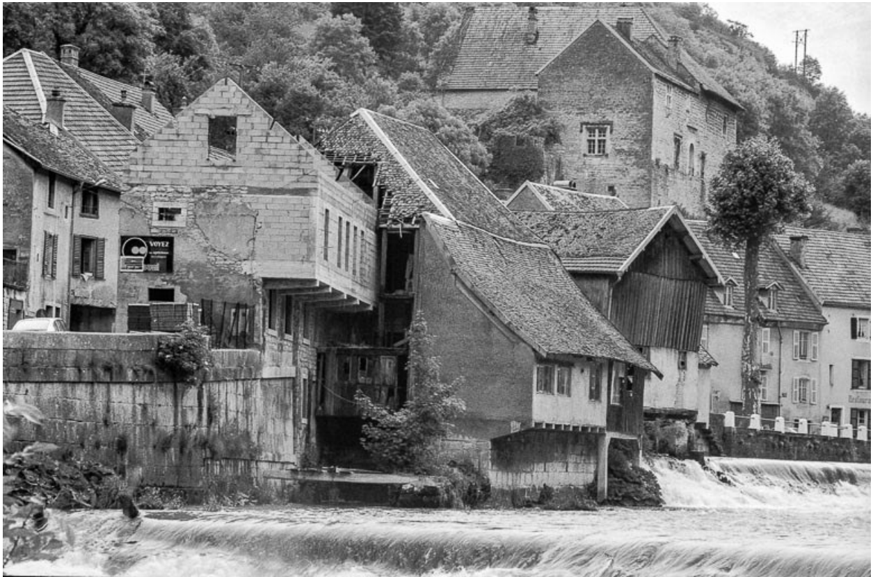
Vue rapprochée depuis l'ouest en 1980.
