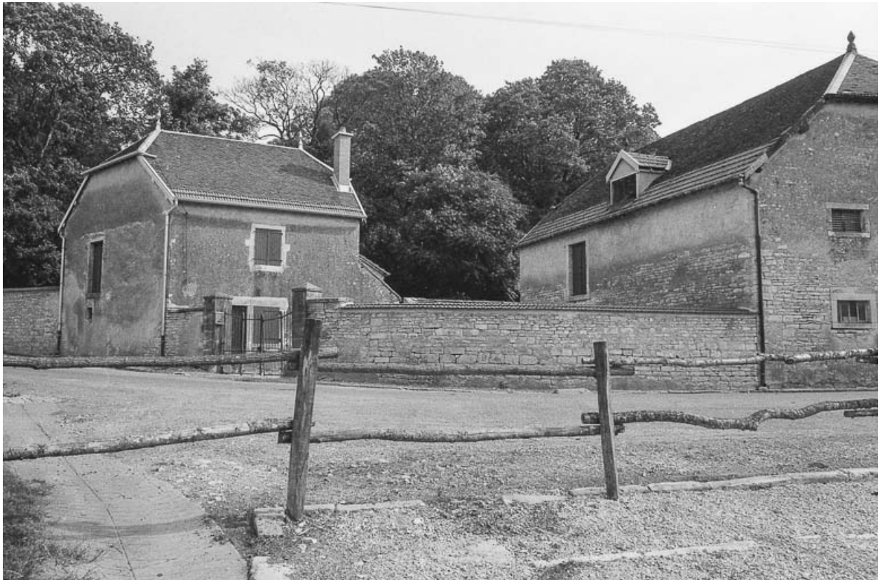
Ferme et pavillon d'entrée.
