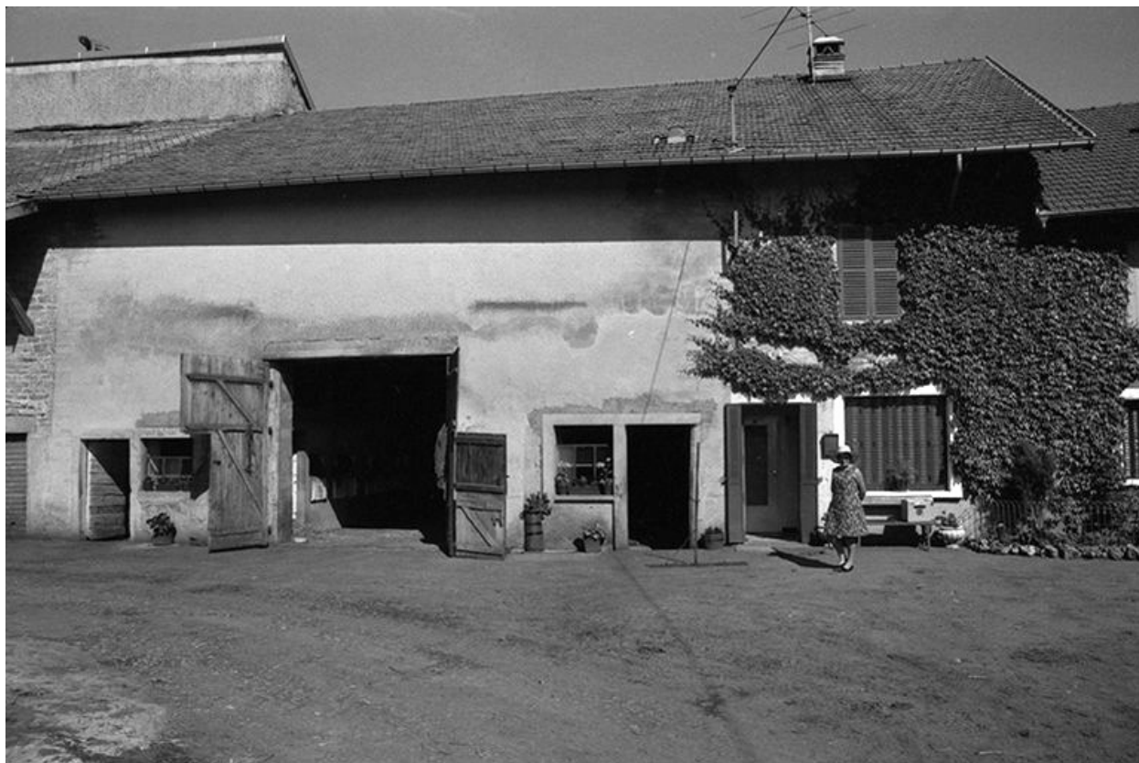
Ferme cadastrée 1957 A1 64 : façade antérieure.
