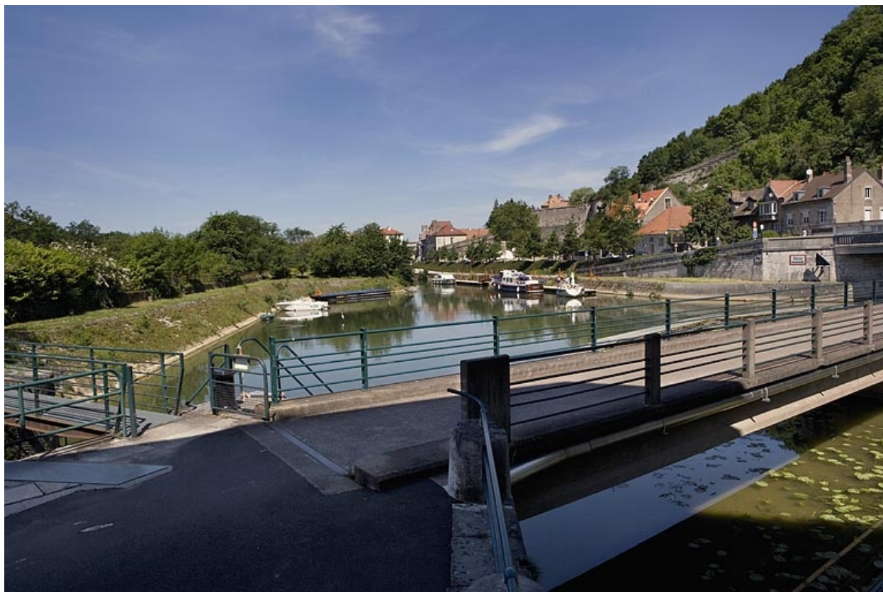
Vue d'ensemble depuis l'écluse n° 51.
