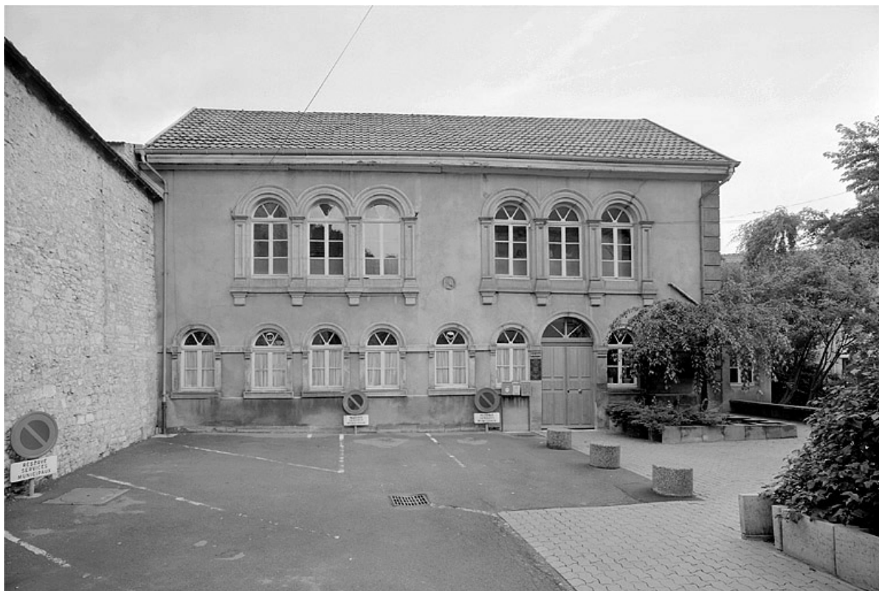
Bâtiment des Bains. Façade sur cour.
