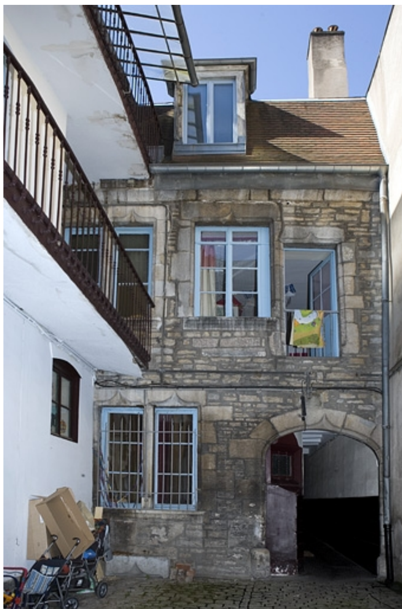
Façade postérieure du logis principal, de face.
