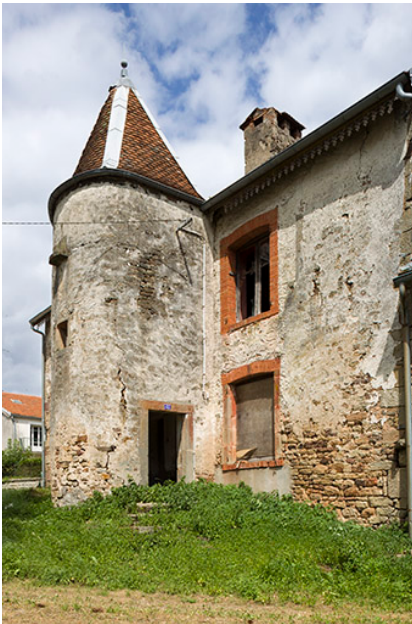
Vue sur la tourelle d'escalier.
